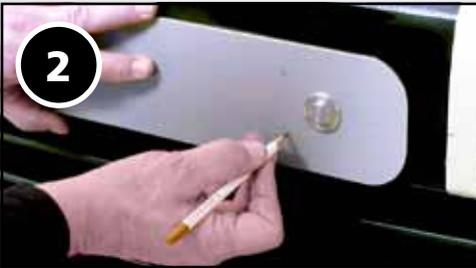
Auf der Grundplatte die gewünschten Befestigungsbohrungen markieren.
